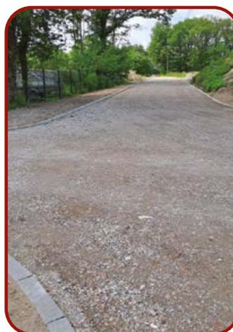
L'ensemble des terrains de la zone artisanale du guidon ayant été vendu, la construction d'une route desservant ces parcelles est maintenant nécessaire. Après le passage des différents réseaux et la pose des bordures, la structure de la chaussée et l'enrobé ont remplacé l'ancien chemin du Guidon.
